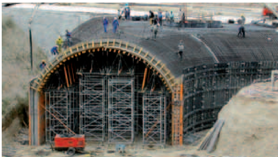
Soterramiento Aeropuerto de Barajas, Madrid, España
