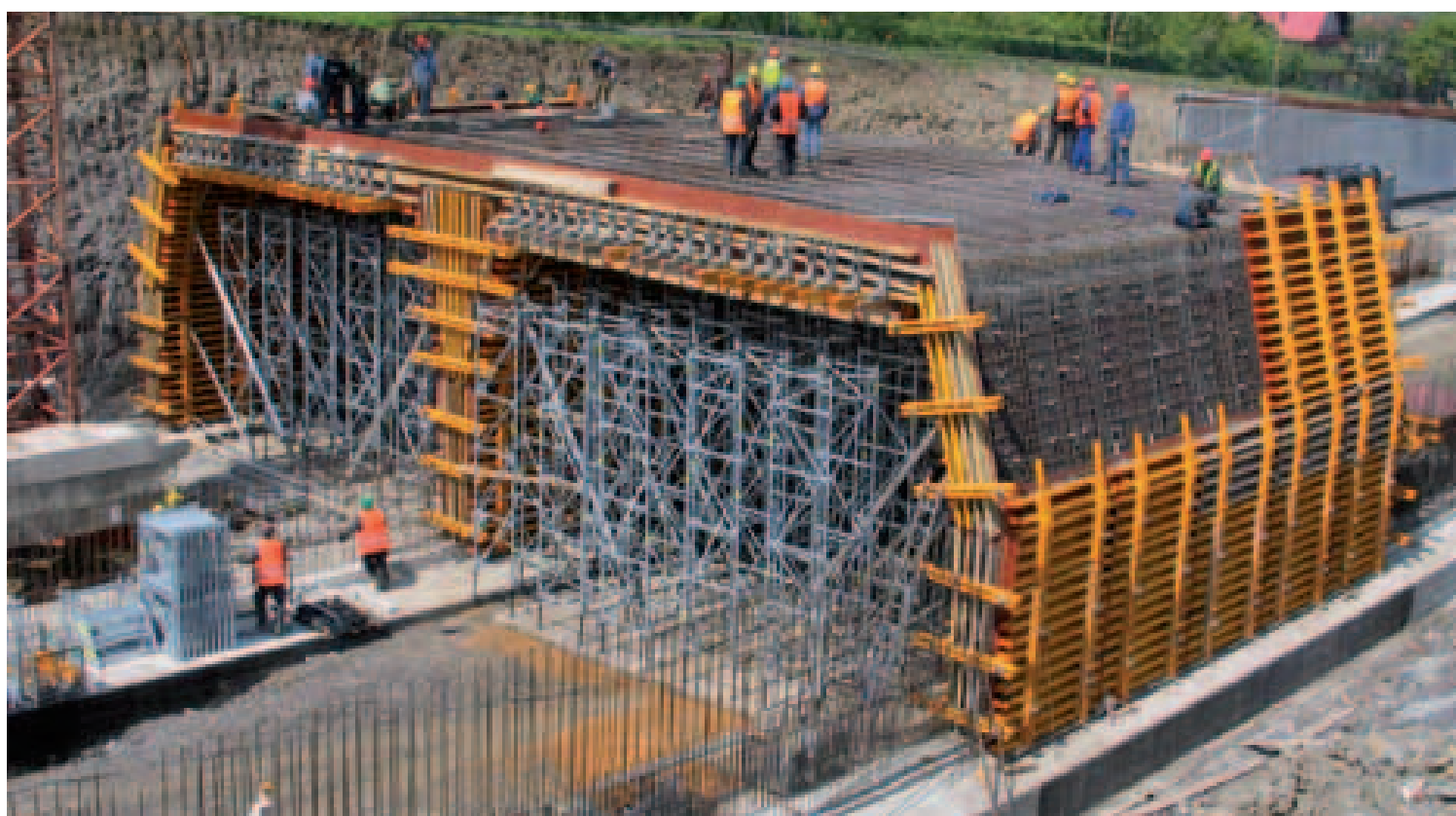
Aplicación en paso superior y falso túnel
