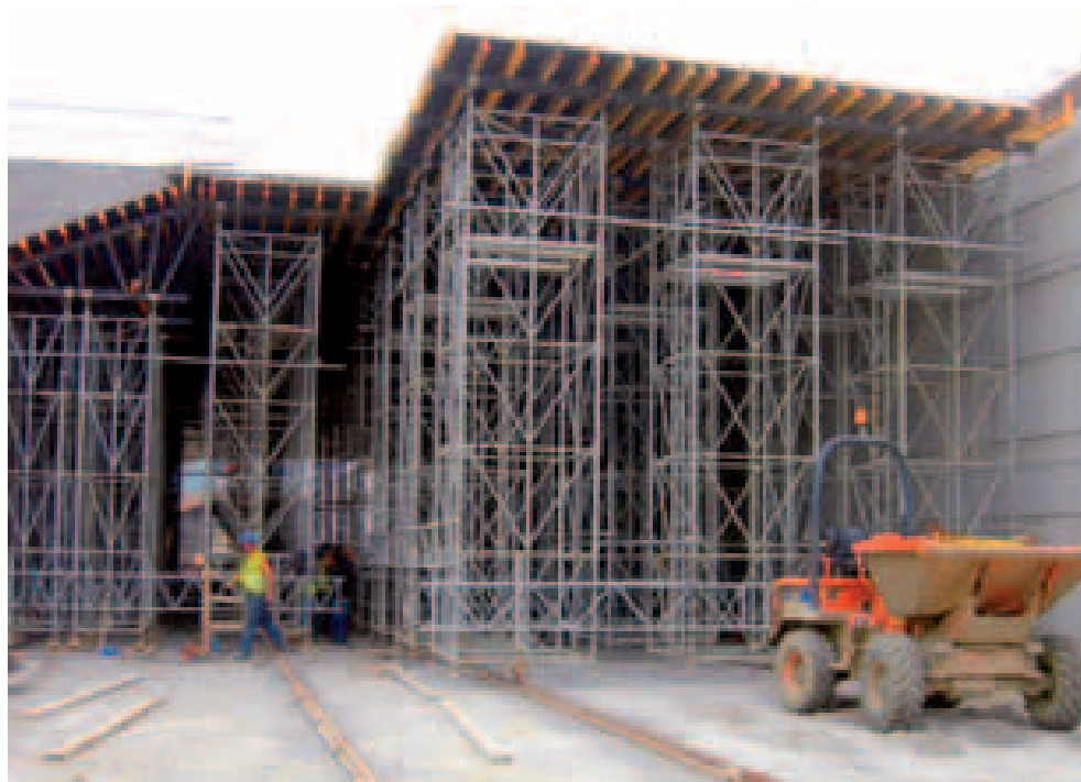
Paso inferior con desplazamiento del tablero sobre railes
